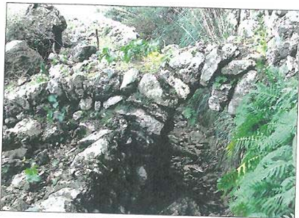
Pontet al torrent de sa Coveta Negra
