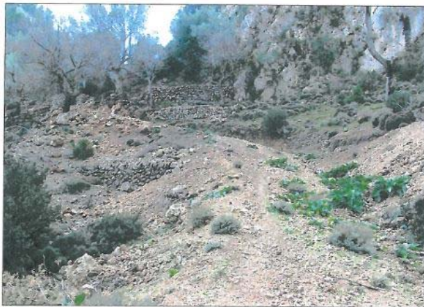
Problemes associats a l'obertura de pistes
